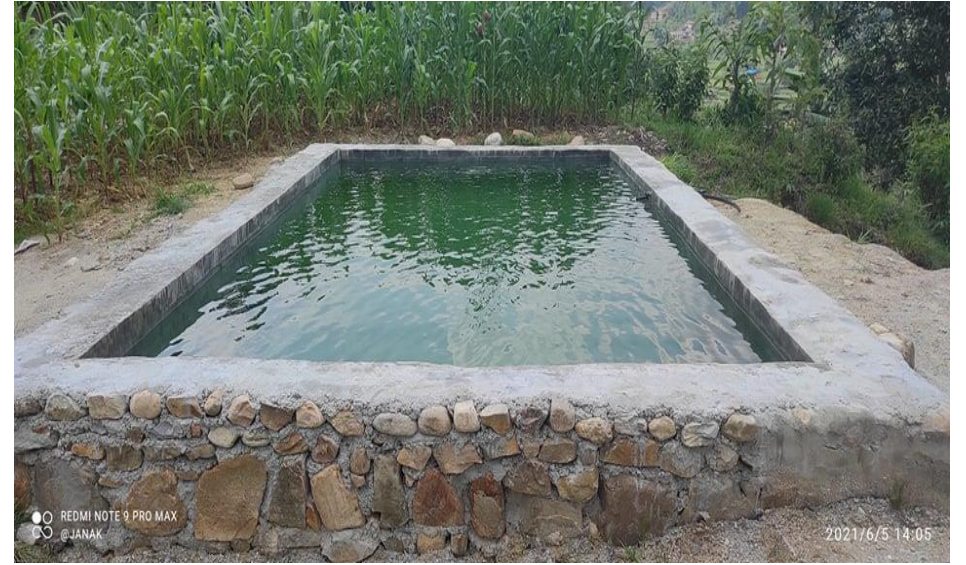
सानासिंचाईको लागि पानी टंकी/पोखरी निर्माण
