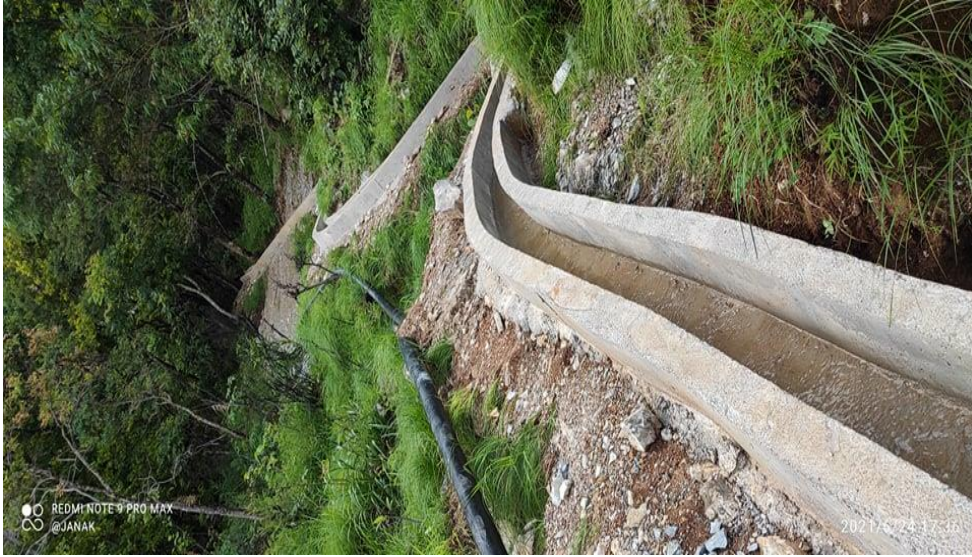
साना सिंचाईको लागि कुलो निर्माण
