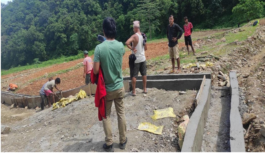
चक्लावन्दीमा सिंचाई कुलो निर्माण
